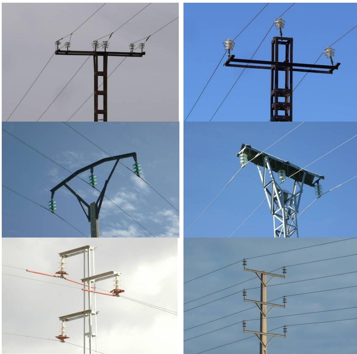
Figuras 4.2 a 4.7: apoyos de alineación por tipología de cruceta (de arriba abajo y de izquierda a derecha): plana, en cruz, en bóveda, en bóveda de celosía, en tresbolillo y en tresbolillo doble (este último con aislador rígido)
