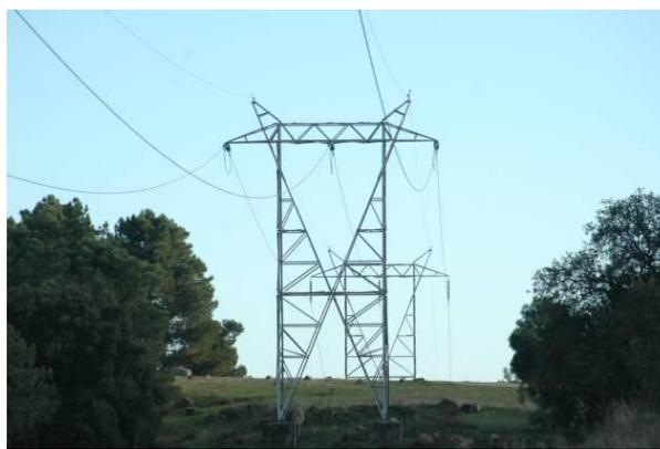
Figuras 1.2 y 1.3: líneas de transporte de categoría especial (>220 kV) y de 132 kV, ambas con cable de tierra, que resulta más complicado de distinguir
