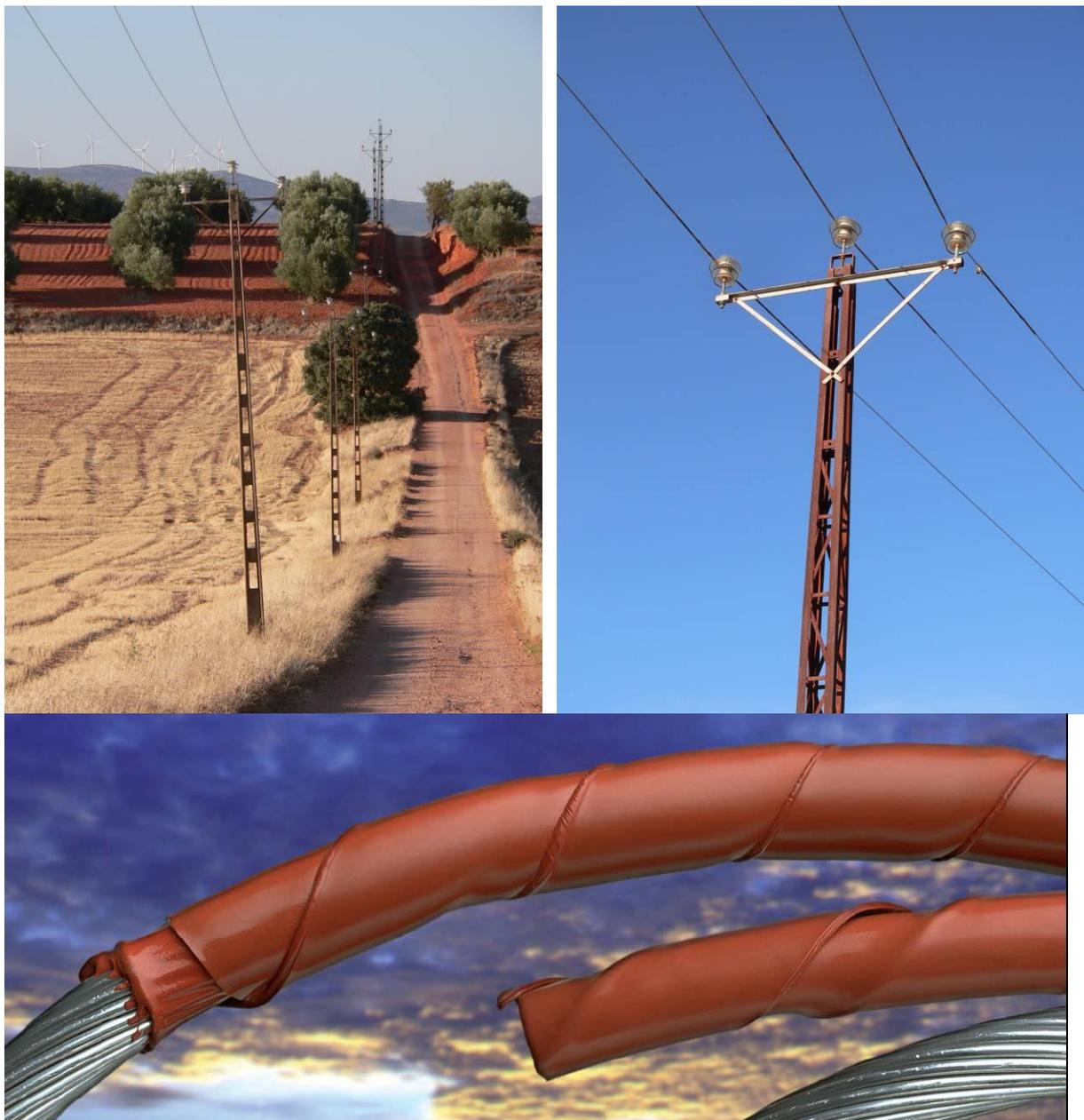
Figuras 1.8 a 1.10: aspecto del tendido de Las Cañas (T.M. Valdepeñas, Ciudad Real), detalle del aislamiento efectuado en el marco del Plan de Actuaciones coordinado y detalle del aislamiento OLIT-M en rojo (tomado del catálogo del producto, <http://www.te.com/en/industries/energy.html>)
