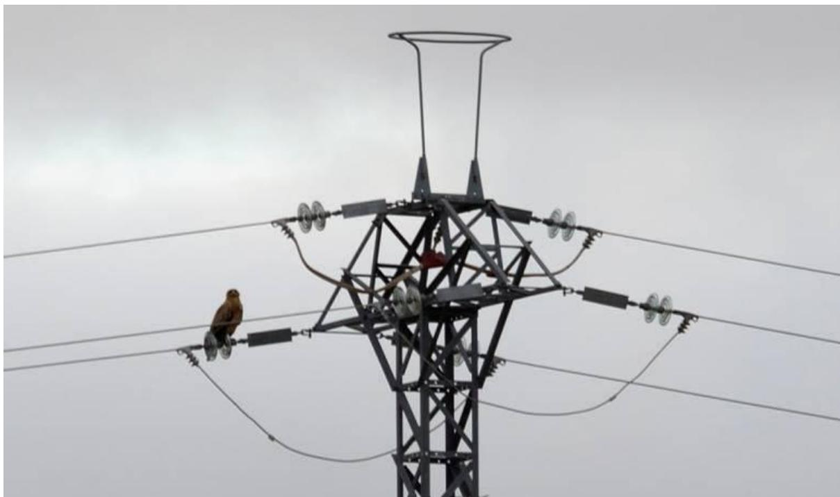
Figura 4.14: pollo de águila imperial ibérica posado en cadena de aisladores en tendido modificado en Toledo
