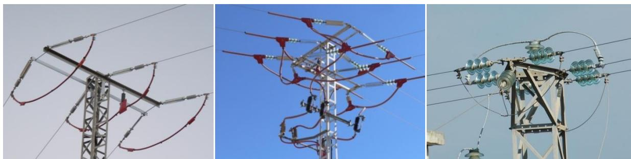
Figuras 5.1. a 5.3: Corrección de tendidos tipo LIFE, tipo FEDER y tipo aislamiento (éste último no es un tendido seguido en el proyecto)
