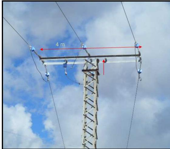
3º.- Colocación de alargaderas (6 unidades.) con placa antiposada en los tres conductores
